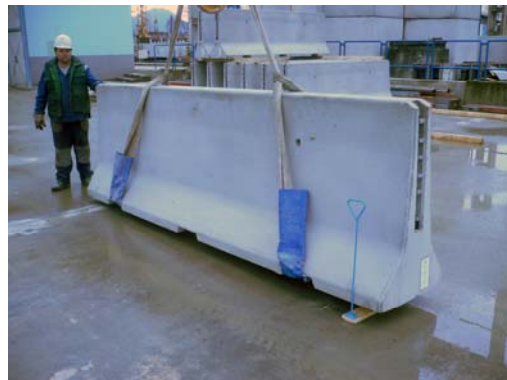
Preprava dielca zvodidla na miesto uloženia
