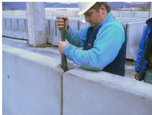
Zasunutie lamiel „B“ montážnymi kliešťami
