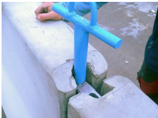
Vytáhovanie spojovacích tyčí \varnothing 22 mm prípravkom
