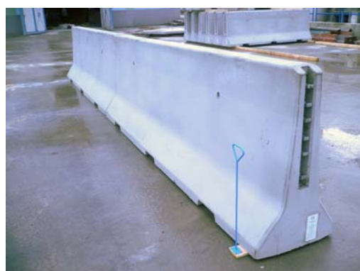
Zvodidlo pripravené na montáž ďalšieho dielu
