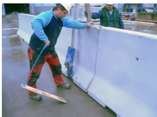
Vybranie podkladového klinu spod dielu
